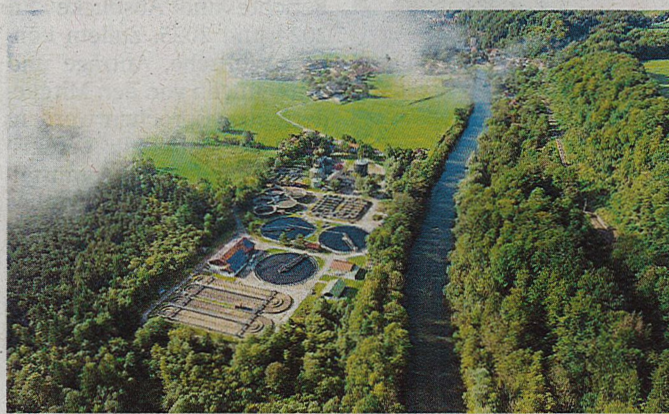
Die Kläranlage in Weidach: Das Gesamtvolumen ihres Etats liegt bei über 6 Millionen Euro.
