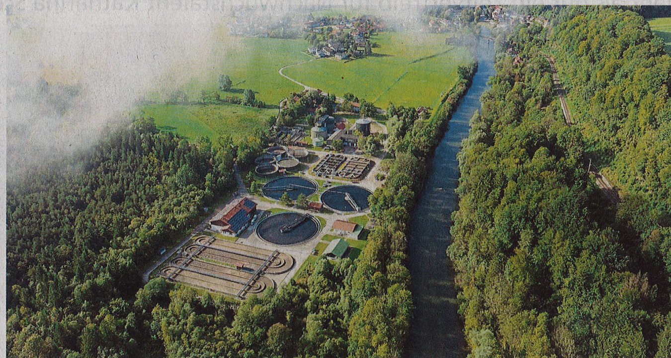
Teile der Kläranlage in Weidach sollen saniert werden. Bevor die Arbeiten beginnen, möchten die Bürgermeister der angeschlossenen Kommunen genau wissen, was die Baumaßnahmen kosten.
