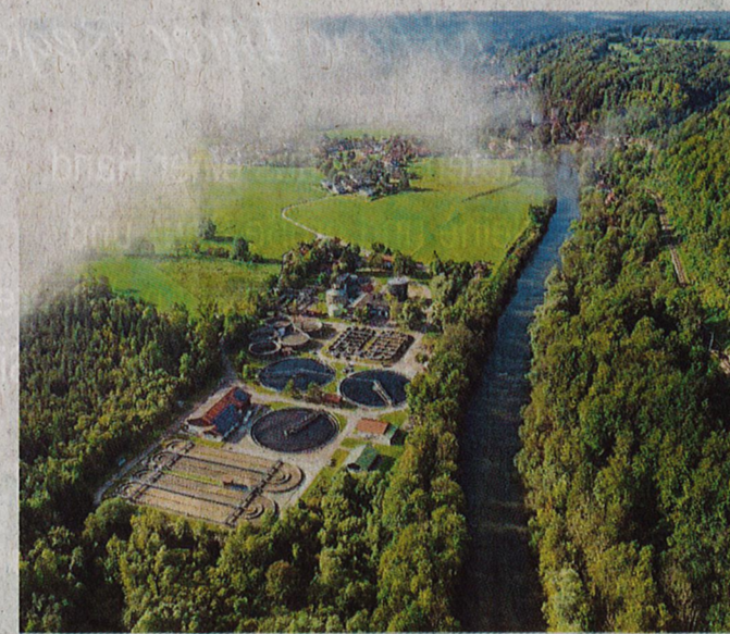
Die Kläranlage in Weidach nimmt die Abwässer von sechs Kommunen auf, darunter Königsdorf. Foto: hl/archiv
