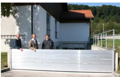
Hochwasserschutz Abfahrtsrampe BHKW
