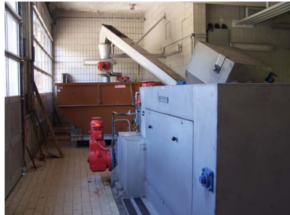
Rechenanlage mit Containerverladung
