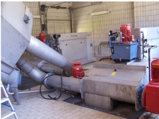
Rechenanlage mit Containerverladung
