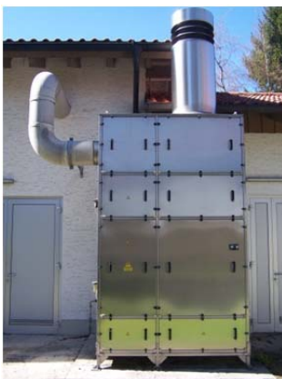
Abluft-Wäscher zur Behandlung der geruchsbeladenen Luft aus dem Rechengebäude
