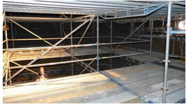
Bild 8: Gerüst im Faulbehälter
