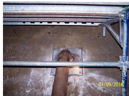
Bild 14: geänderte Rohreinführung
