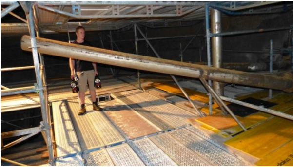
Bild 7: Begehung des Faulbehälters
