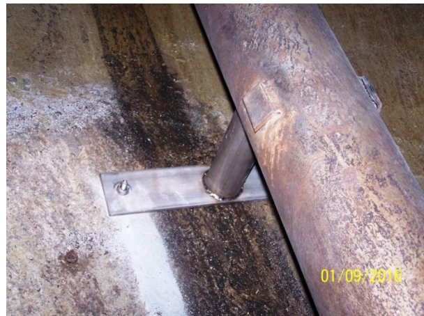
Bild 12: abgeänderte Rohrhalterung
