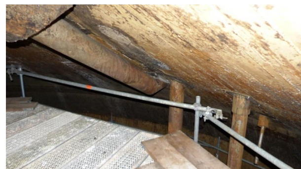
Bild 6: Gerüst im oberen Faulbehälterbereich
