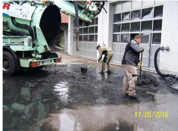
Bild 2 Entsorgung der Verzopfungen
