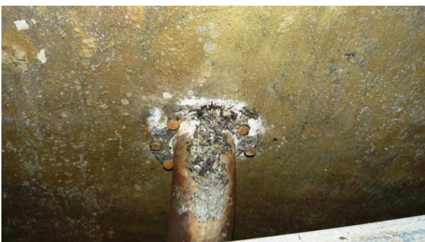
Bild 13: schadhafte Rohrdurchführung
