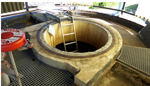
Bild 5: Einstieg in den Faulbehälter von oben
