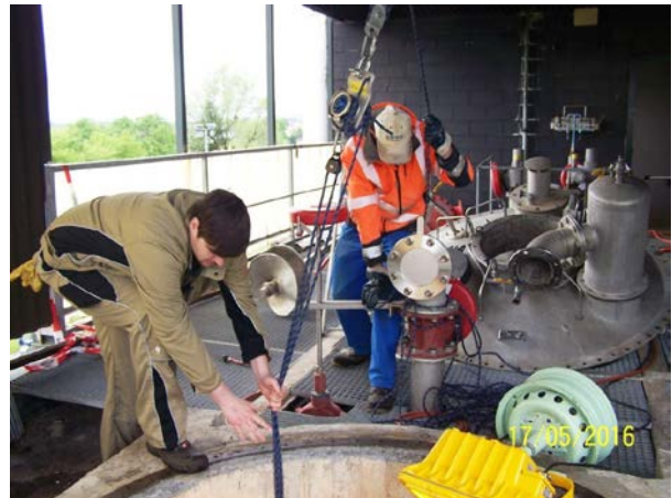
Bild 4: Arbeiten am Faulbehälterkopf
