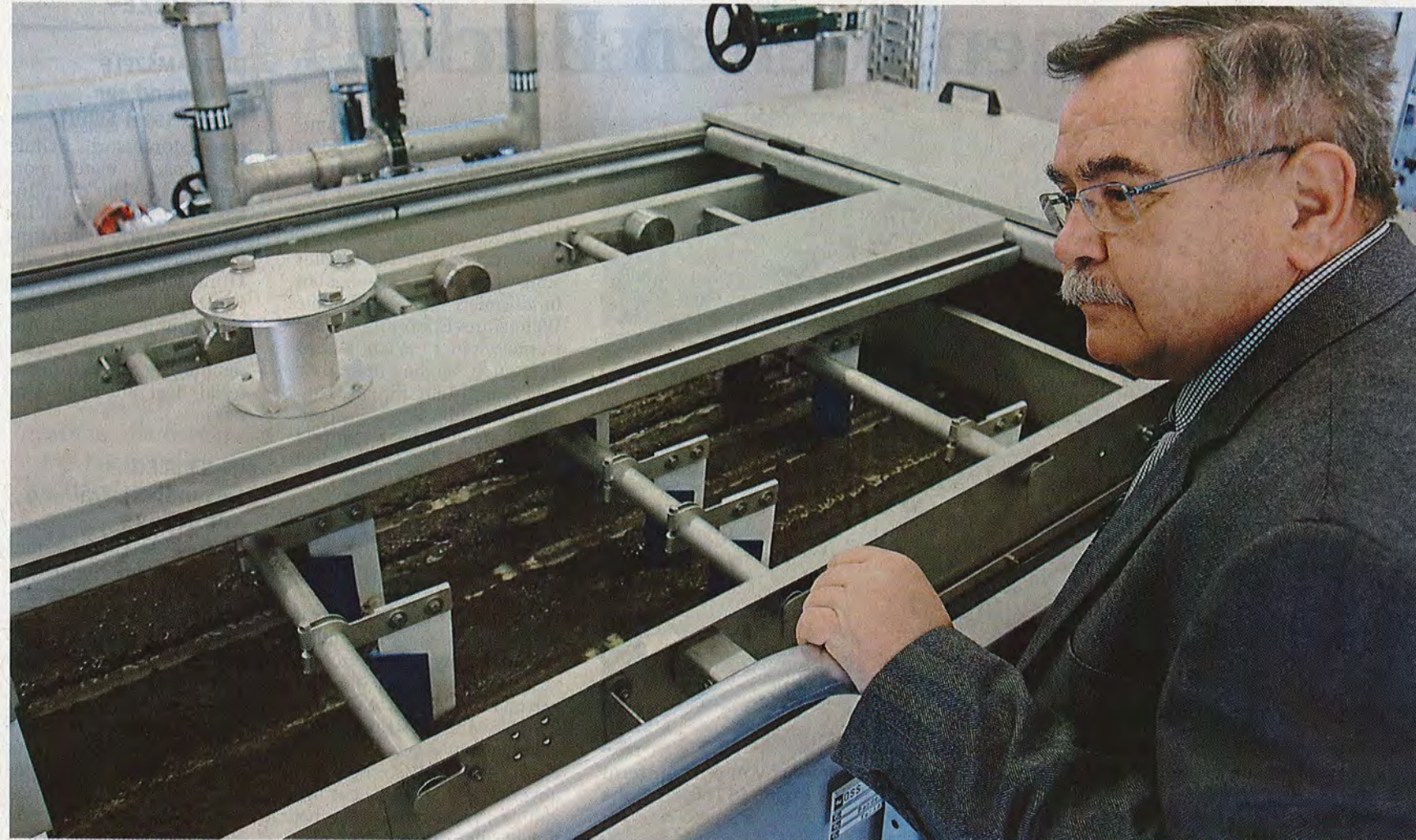
Überwachte die Inbetriebnahme der Anlage zur maschinellen Überschussschlamm-Eindickung: Der Geschäftsführer des Klärwerks, Dr. Stephan Hartwig. FOTO: SH
